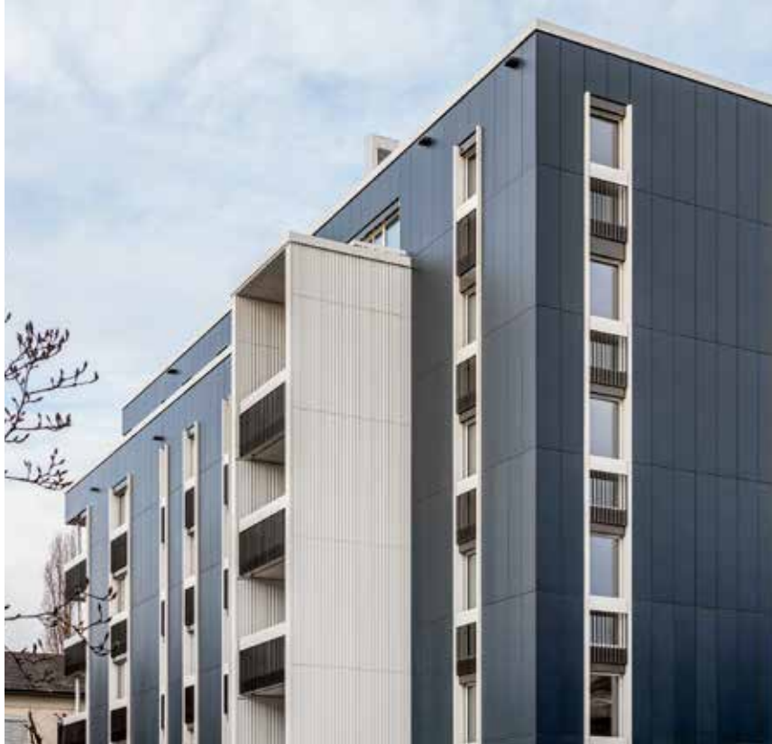
Bei der Planung setzte die Graphis nicht auf maximalen Solarertrag, sondern auf eine gute Gestaltung und Funktionalität. Die dunklen Module setzen sich deutlich von den hellen Fensterkolonnen ab.
